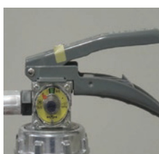
× 安全栓の脱落
